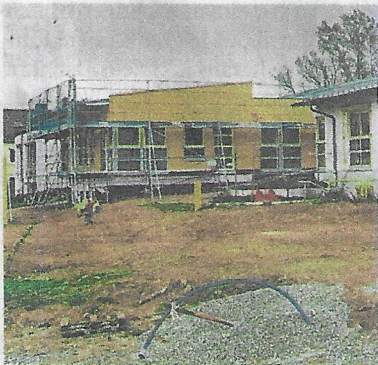
Die Erweiterung der Kindertagesstätte liegt gut im Zeitplan. Sie soll noch vor Beginn des neuen Kindergartenjahres abgeschlossen sein. Foto: Armin Schmid
